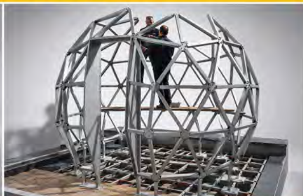
عملیات نصب و مونتاژ سازه گنبدی فضاکار Installation & Assembly of Geodesic Dome
